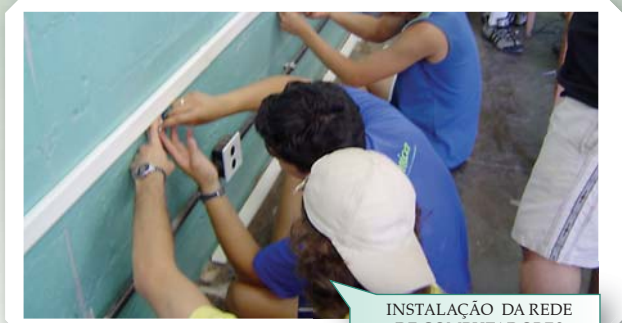
INSTALAÇÃO DA REDE DE COMPUTADORES
