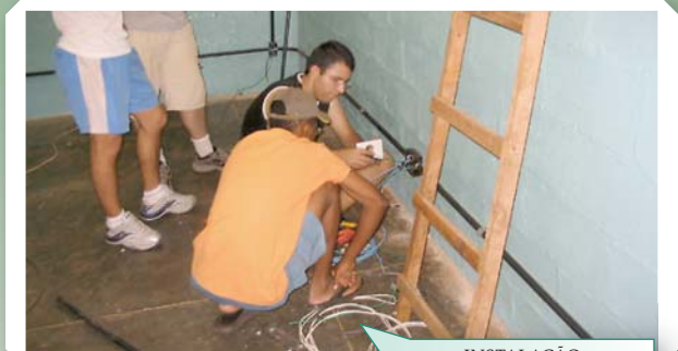
INSTALAÇÃO DAS TOMADAS
