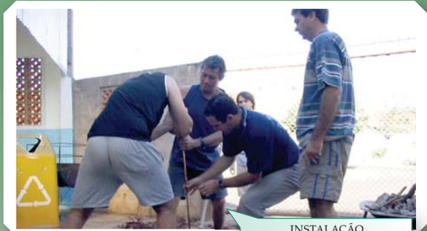
INSTALAÇÃO DO ATERRAMENTO
